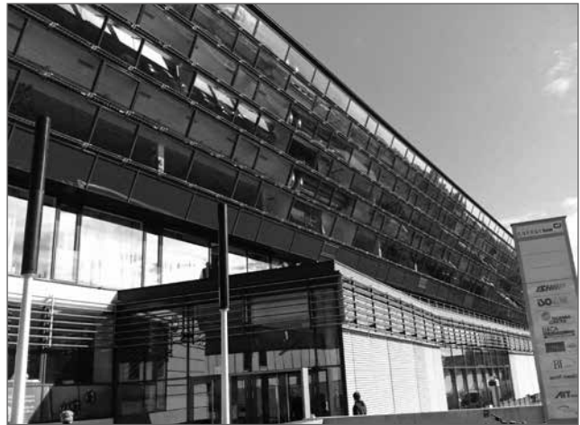
Abb. 6: Projektpartnergebäude E-Office Energie Steiermark Graz
